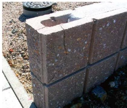
施工不良によりブロック内部へ雨水が浸入したため、内部に水がたまり、その水が凍結と融解を繰り返す凍結融解作用によって、ブロックが破壊されている例。
